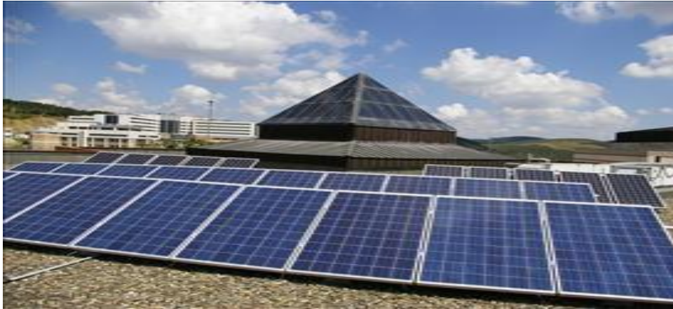
Şekil 3: Fotovoltaik sistemde kullanılan polikristal güneş panelleri [10]
